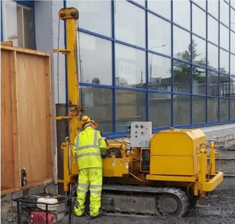
Figure 1 Mini Piling Rig
